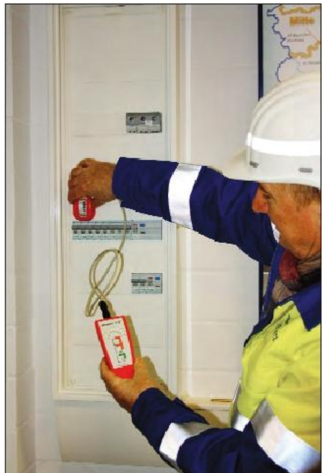
Bild 6: Im Elektrohandwerk kann das System u. a. auch zur sicheren Stromkreis- und Kabelbestimmung eingesetzt werden
