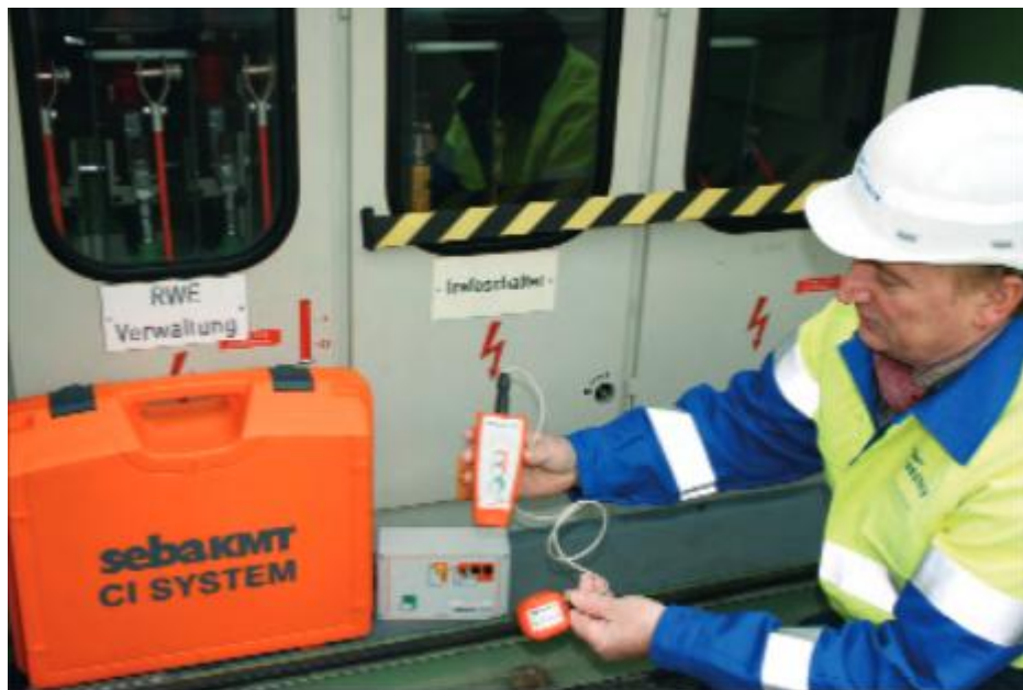
Bild 1: Das Kabelauslesegerät SebaKMT CI/LCI von Megger kommt bei Westnetz zum Einsatz
