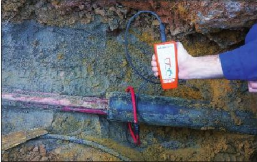
Bild 3: Ohne Kenntnis der richtigen Polarität nützt der auf der Stromzange angebrachte Pfeil nichts – und das ist im Feld mitunter schwierig
